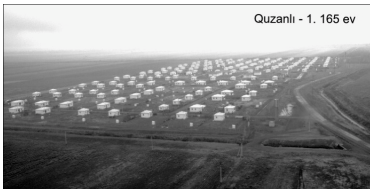
Nově postavená vesnice Qazanli, domů 165 Zdroj: Státní úřad pro IDP a uprchlíky
